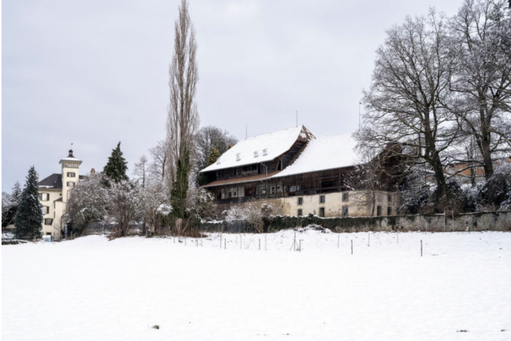
Die Scheune in Kirchdorf wurde vor über 300 Jahren gebaut. (Bild: Marco Frauchiger)
