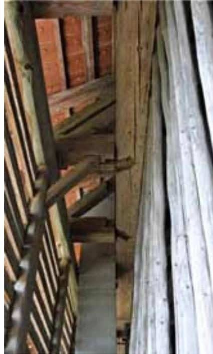
Abb. 125 (LINKS) – Bernseitige Scheune, Gimwand Seite Berg. In die genuteten Pfosten sind Bretter eingeschoben, anders als bei der Gimwand der thunseitigen Scheune, für die aussenbündig eingepasste Bohlen verwendet wurden.
