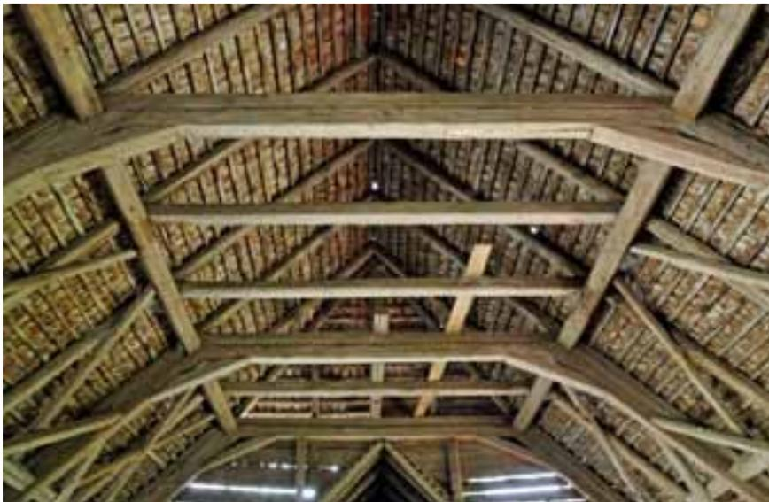
Abb. 134 – Bernseitige Scheune, Dachraum, Blick in Richtung thunseitige Scheune, oberer Teil. Auch hier verfügt jeder Sparrenlauf über einen Kehlbalken, und der First ist pfettenlos ausgebildet. Auffällig ist der grosse Sparrenabstand, der darauf hinweisen könnte, dass der 1704 gezimmerte Dachstuhl ursprünglich für eine Deckung mit Holzschindeln ausgelegt wurde. (Foto: PB/KDP 2017)
