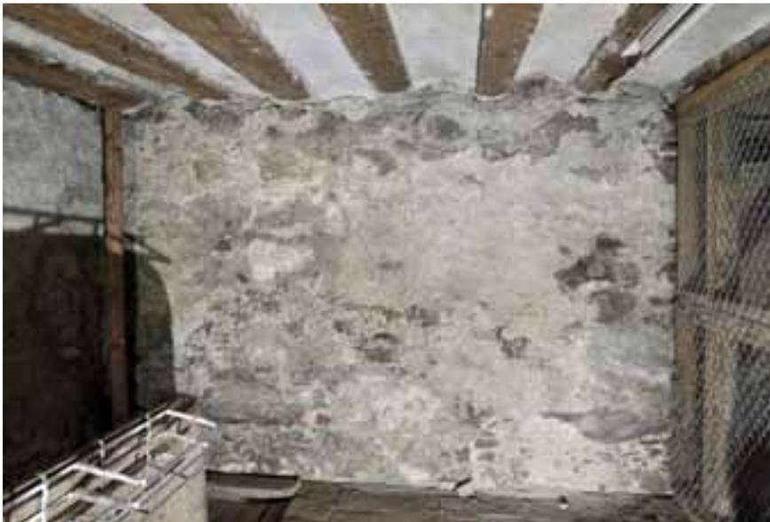
*Abb. 74 – U1.02, Blick Richtung Nordosten auf die Rückwand des ehemaligen Korridors, die gleichzeitig als Stützmauer fungiert. Die aus Backstein gemauerten engen und flachen Deckenkappen wurden fein überputzt und weiss gekalkt. (Foto: PB/KDP 2017)*
