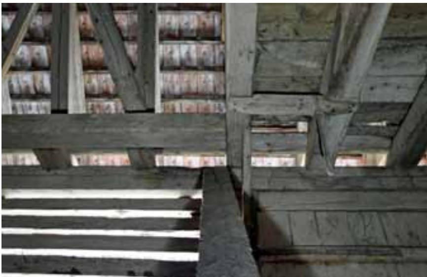
Abb. 116 – Thunseitige Scheune, Blick Richtung Südwesten (talseitige Aussenwand). Hier ist der Übergang vom Bergeraum OG.01 auf die Bühne der Hocheinfahrt OG.02 zu sehen. Die Bühne gehört zum ursprünglichen Bestand der Scheune von 1793 und liegt auf dem Niveau des «Dachbodens». Links unten im Bild erkennt man die Gimwand, rechts davon das Tennor.
