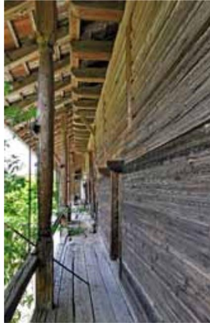
Abb. 43 (LINKS) & Abb. 44 (RECHTS) – Talseite, Laubengang vor der thunseitigen Scheune, Blick Richtung Südosten (LINKS) und Richtung Nordwesten (RECHTS). Die Bretter der Laubenbrüstung fehlen. Die Aussenwände des Erdgeschosses, das hauptsächlich als Speicher und nicht als Stall diente, bestehen aus Holz. Erd- und Obergeschoss sind zusammen abgebunden (durchlaufende Pfosten). Das Erdgeschoss hat Ausfachungen aus liegenden Bohlen, das Obergeschoss ist als Gimwand ausgebildet. (Fotos: PB/KDP 2017)
