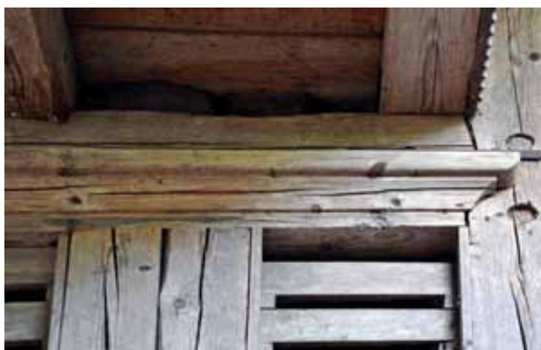
Abb. 22 (OBEN) & Abb. 23 (LINKS) – Bernseitige Scheune, Strassenseite, Tenn. Während das Tenntor links mit der Hocheinfahrt bündig ist (siehe auch Abb. 20), weicht es rechts gegenüber der Hocheinfahrt zurück (Abb. 22). Diese Unregelmässigkeit muss bereits mit der Erneuerung des Stallgeschosses um 1840 entstanden sein, weil man offensichtlich das neue (Futter-)Tenn zugunsten der Stallungen verkleinerte. (Fotos: PB/KDP 2017)
