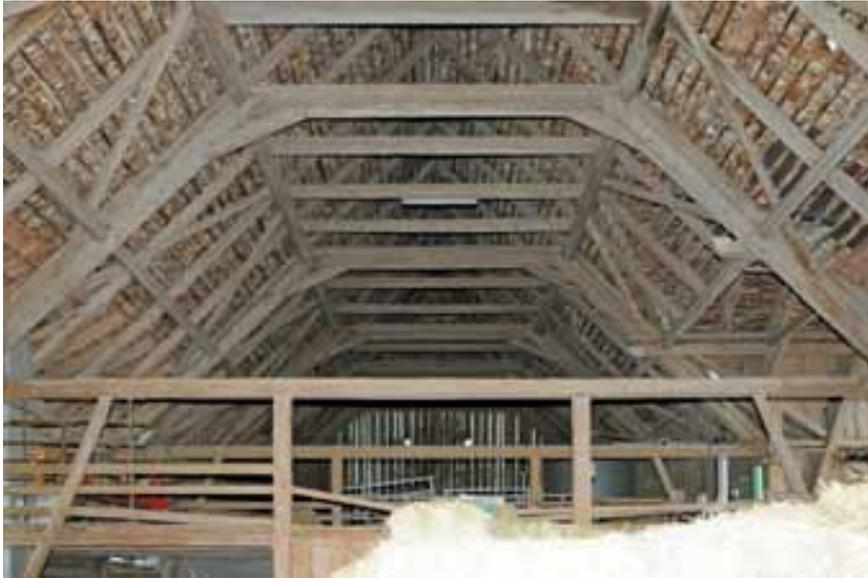
Abb. 140 – Bernseitige Scheune, Blick von der Hochfahrtsbühne Richtung Nordwesten. Die Konstruktionsweise des 1704 gezimmerten Dachstuhls – liegende Binder mit Zwischen- und Mittelfetten, pfettenlose Firstausbildung, Kehlbalken bei jedem Sparrenpaar, Längsaussteifung durch diagonale Windverbände in den Ebenen der Hauptdachschilder, traufseitige Vordachausladung mittels Aufschieblingen – ist hier exemplarisch ablesbar. Der Dachstuhl wurde seit seiner Erstellung zwei Mal umgesetzt!
