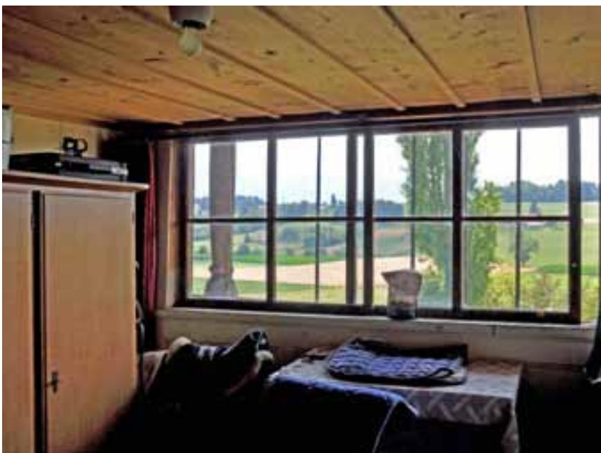
Abb. 97 – Thunseitige Scheune, Knechtenstube EG.10, Blick Richtung Südwesten auf die Fensterfront. Das ursprüngliche kleine Fenster wurde mit dem Ausbau der Sattelkammer zur Knechtenstube auf die gesamte Breite des Raums vergrössert. (Foto: PB/KDP 2017)
