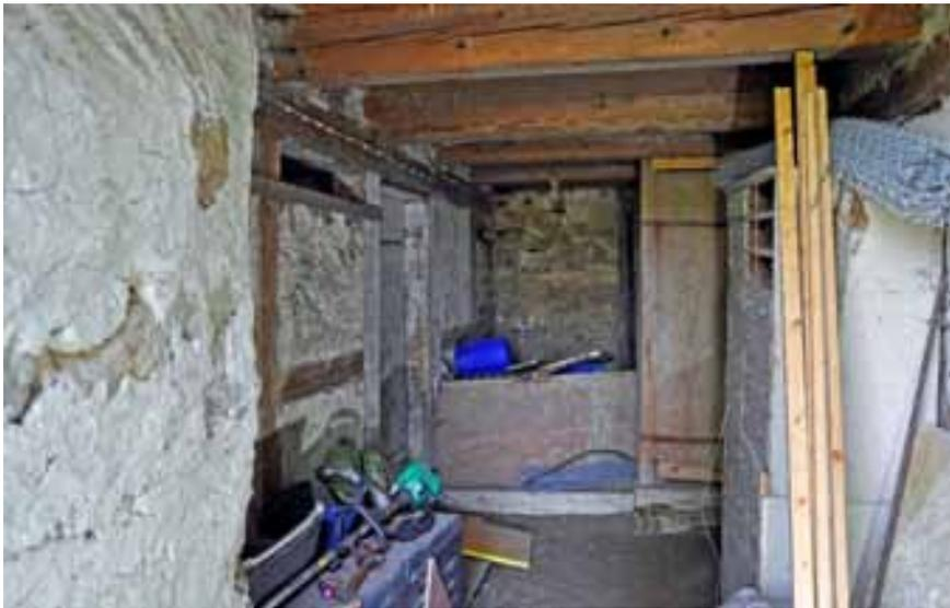
Abb. 54 – Korridor U2.02, Blick Richtung Nordosten. Links die Leibung der Türnische in der sehr dicken, zweischaligen Aussenwand. Anschliessend die Fachwerkwand zum Kellerraum U2.03 mit Tür.
