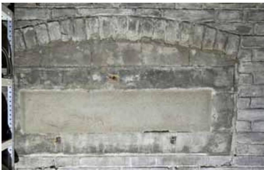
Abb. 104 – Bernseitige Scheune, ehemaliges Tenn EG.13, Detailausschnitt der bernseitigen Wand zum benachbarten Stall EG.15. Die auf Sicht mit Zement- oder Kalksandstein gemauerte Wand hat ebenfalls Futteröffnungen, die aber im Laufe des 20. Jh. vermauert worden sind. Dieses Mauerwerk steht in Zusammenhang mit einer Sanierung des Stalls EG.15, die gleichzeitig mit der Aufstockung der bernseitigen Scheune 1898 durchgeführt wurde.
