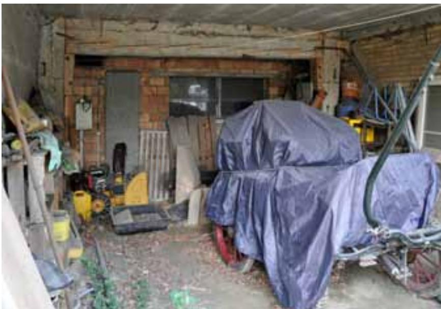
Abb. 111 – Bernseitige Scheune, Einstellraum EG.18 im bernseitig angebauten Schopf, Blick Richtung Südosten. Die Scheune endete ursprünglich auf der Ebene des hölzernen Unterzugs, wo sich deren Aussenwand befand. Später wurde die Raumtiefe vergrössert, insbesondere auch im benachbarten Raum, der zum Autoeinstellraum umfunktioniert wurde. Die Backsteinwand im Hintergrund gehört zum Umbau des Raums EG.16 in einen Schweinestall.
