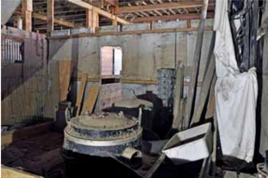
Abb. 86 – Thunseitige Scheune, Raumbereich thunseitig des Tenns, ehemaliger Speicherraum EG.06, Blick Richtung Osten. Die ursprüngliche Raumteilung fehlt; die Einbauten stammen alle aus der 2. Hälfte des 20. Jhs. (Foto: PB/KDP 2017)
