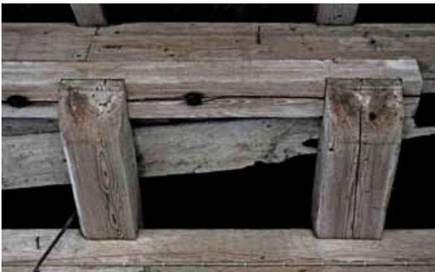
Abb. 15 – Thunseitige Scheune, Strassenseite. Der Ausschnitt zeigt den Übergang von der Wand zum traufseitigen Vordach. Die über die Wandebene nach aussen vorspringenden Bundbalken (im Bereich der Binder) bzw. der Stichbalken tragen eine Schüpfpfette, die später oben mit einem zweiten Balken aufgedoppelt wurde. Die Schüpfpfette trägt die Sparren-Aufschiebblinge.
