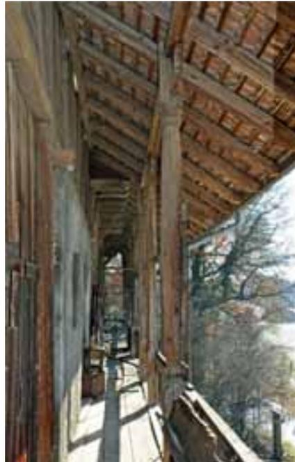
Abb. 34 (LINKS) – Talseite, Laubengang vor der thunseitigen Scheune, Blick Richtung Nordwesten. Rechts das Fenster der Knechtenstube. Der dort eingefügte Raum diente ursprünglich als Sattelkammer und verfügte lediglich über ein bescheidenes Fenster. In Bildmitte ist der Wechsel von der hölzernen Erdgeschosswand auf das Mauerwerk im Stallbereich der bernseitigen Scheune zu sehen.
