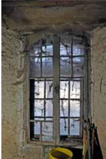
Abb. 59 (RECHTS) – U2.01, Blick Richtung Südenwesten. An der Talseite ist die Mauer offensichtlich zweischalig ausgebildet und ungewöhnlich dick. Die Fenster sitzen in entsprechend tiefen Nischen.
