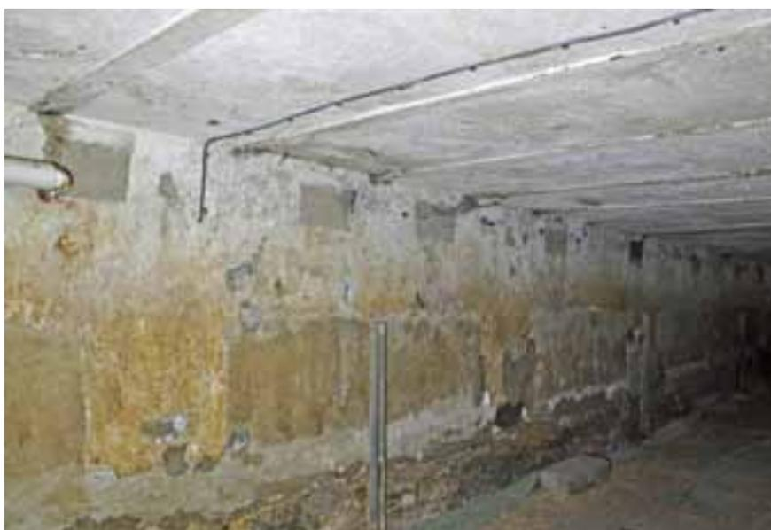
Abb. 106 – Bernseitige Scheune, Stall EG.15, Blick Richtung Süden. Die Stallwand zum Tenn wurde 1898 durch eine neue Zement- oder Kalksandsteinmauer ersetzt, die man stallseitig verputzte. Später wurden die Krippen herausgebrochen und die Futteröffnungen vermauert, wie die Spuren an der Wandoberfläche belegen. Gut sichtbar ist die Tonhourdisdecke mit Stahl-Doppel-T-Trägern. Die Unterseiten der Hourdis wurde überschlämmt und gestrichen. (Foto: PB/KDP 2017)
