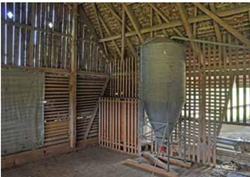
Abb. 124 – Bernseitige Scheune, Bergeraum und Dachwerk, Blick Richtung Norden. Die mit enggestellten Latten versehene Gimwand unterhalb der vertikalen Verbretterung der Stirnwand war aussen nie sichtbar. Dort befindet sich der Dachraum über dem bernseitig angebauten Schuppen, der mit einem Pultdach an die alte Scheune anschliesst. Im Bereich des Dachwerks ist die Längsaussteifung mit den sich kreuzenden Diagonalen zu erkennen.
