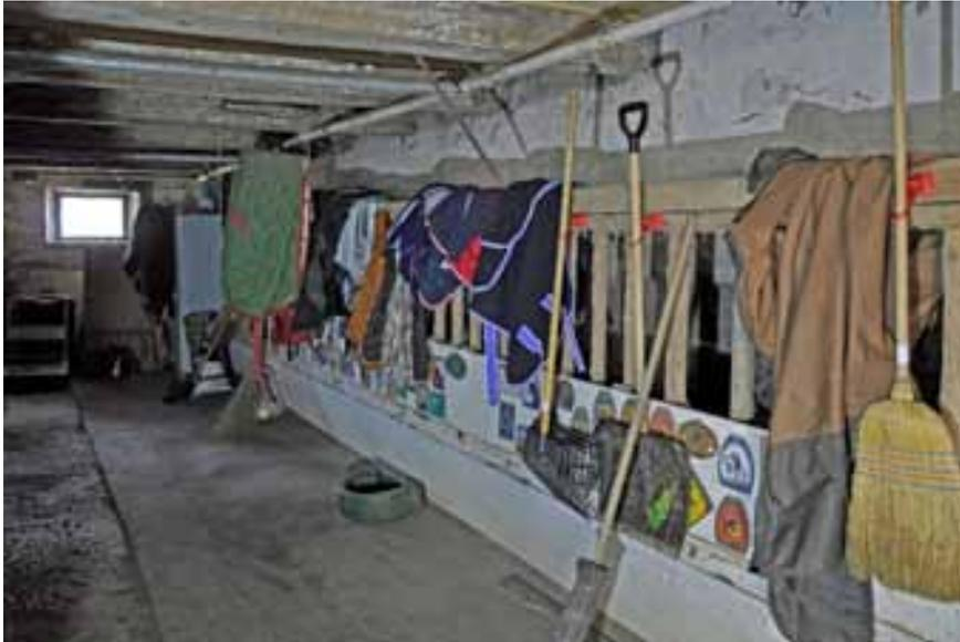
Abb. 98 – Bernseitige Scheune, Stall EG.12, Blick Richtung Westen. Der Stall wurde im frühen 20. Jh. saniert, wobei die Mauer zum Tenn (rechts im Bild) mitsamt der Futterkrippe neu erbaut wurde. Die Decke behält in konventioneller Art eine Holzbalkenlage mit Bretterbedeckung. (Foto: PB/KDP 2017)
