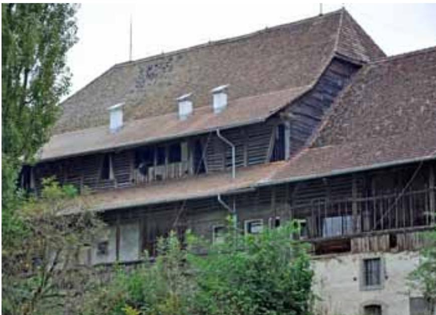
Abb. 31 – Talseite, Übergang von der thunseitigen Scheune (rechts) auf die höhere bernseitige. Ansicht von Süden. Gut zu sehen ist der Laubengang, der auf der Krone der Stützmauer vor den beiden Scheunen über deren gesamte Länge läuft. Nachdem die bernseitige Scheune 1898 aufgestockt worden war, erhielt der dortige Abschnitt der Laube ein eigenes Vordach auf der Traufhöhe der thunseitigen Scheune.
