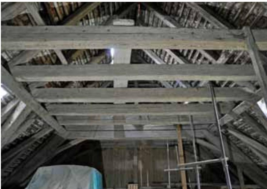
Abb. 127 – Thunseitige Scheune, Dachstuhl von 1793, Blick Richtung Südosten. Über den Mittelpfetten des Dachstuhls liegt konsequent bei jedem Sparrenlauf ein Kehlbalken. Der obere Teil des Stuhls ist ohne Firstpfette ausgeführt.
