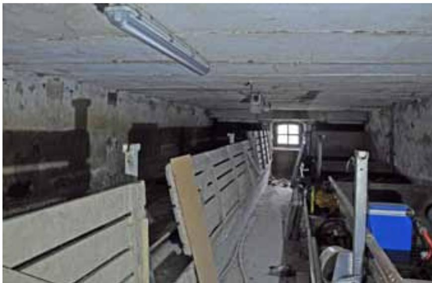
Abb. 105 – Bernseitige Scheune, Stall EG.15, Blick Richtung Südwesten. Der Stall erhielt anlässlich der Sanierung 1898 – gleichzeitig mit der Aufstockung des Bergeraums der bernseitigen Scheune – eine neue Decke aus überbetonierten Tonhourdis, die auf Stahl-Doppel-T-Trägern liegen. Zur gleichen Zeit wurden talseitig die Öffnungen für das Stallfenster und die Tür verändert. (Foto: PB/KDP 2017)
