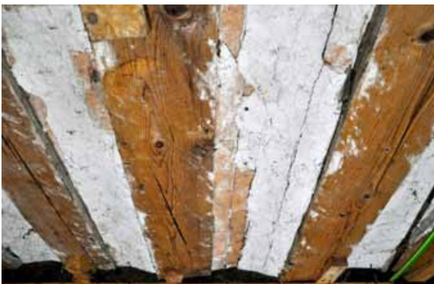
*Abb. 75 – U1.02, Detailansicht der Decke mit ihren enggestellten Balken und den Preussischen Kappen aus Backstein, die mit einem dünnen, weiss gekalkten Deckputz versehen sind. Kappendecken dienten als Brandschutzmassnahme, führten aber auch zu einer Verbesserung des Raumklimas. Die eingebaute schwere Masse führt zu einer Phasenverzögerung im Temperaturverlauf; die Temperaturspitzen sind gebrochen, das Raumklima ausgeglichener als ohne Ausmauerung. (Foto: PB/KDP 2017)*
