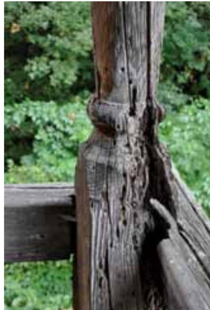
Abb. 45 (LINKS) – Talseite, Vordach, Blick nach oben. Die Säulen dienen nicht der Abstützung des Vordachs, sondern als Pfosten für die Befestigung der Laubenbrüstung.
