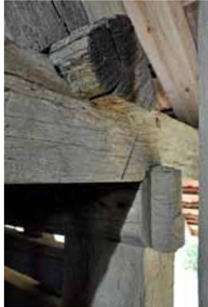
Abb. 117 (LINKS) – Thunseitige Scheune, Bergeraum, Blick Richtung Nordwesten auf den bernseitigen Abschluss der Scheune, der im Dachbereich wiederum mit einem Binder erfolgt. Der Pfosten rechts davon gehört bereits zur anschliessenden bernseitigen Scheune.
