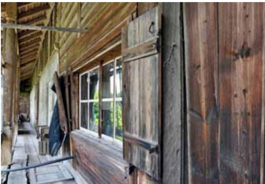
Abb. 42 – Talseite, Laubengang vor der thunseitigen Scheune, Blick Richtung Nordwesten. Rechts das später eingebaute Fenster der Knechtenstube. Der dort eingefügte Raum diente ursprünglich als Sattelkammer und verfügte lediglich über ein bescheidenes Fenster. Links des Fensters befindet sich der Ausgang von der Scheune auf die Laube.
