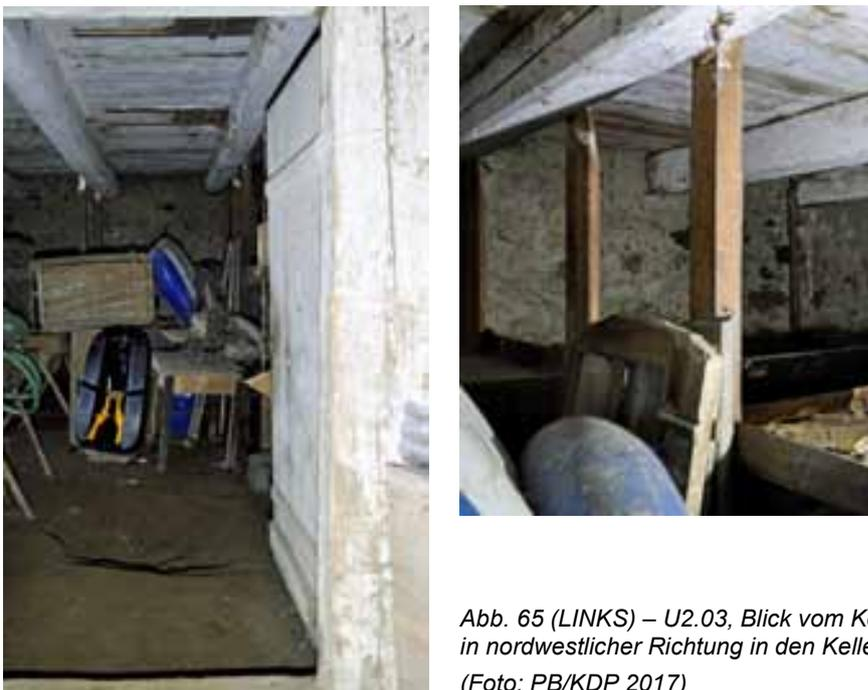
Abb. 64 (UNTEN) – U2.03, Blick Richtung Norden in die hintere Raumecke. Die Stützen stammen aus der jüngsten Vergangenheit und haben keine tragende Funktion, sondern dien(t)en der Nutzung des Raums.
