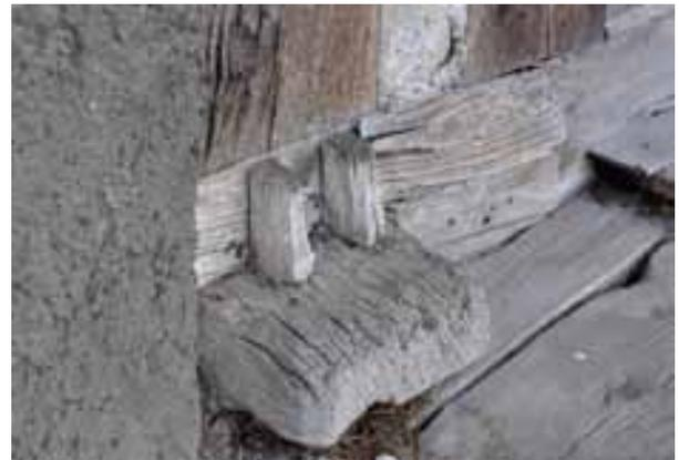
Abb. 40 – Talseite, Übergang von der thunseitigen auf die bernseitige Scheune, Blick nach oben, Richtung Nordwesten. Vorn die Vordachabstützung mittels Bund- und Stichbalken und Schüpfpfette. Hinten das Pultdach an der bernseitigen Scheune. Die dort statisch notwendige Pfette wird von den Laubenpfosten getragen. (Foto: PB/KDP 2017)
