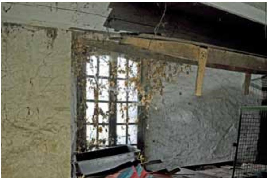
Abb. 63 – U2.03, Blick Richtung Westen auf die talseitige Mauer mit der tiefen Fenster-nische. Die barocke Verglasung ist wiederverwendet.
