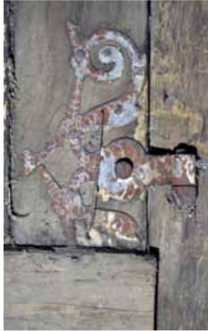
Abb. 94 (LINKS) & Abb. 95 (RECHTS) – Thunseitige Scheune, Korridor EG.11, talseitige Tür, die auf den Laubengang führt. Für das Türblatt wurden reich punzierte und verzinnte Spiralbänder aus dem 17. Jh. wiederverwendet. (Fotos: PB/KDP 2017)
