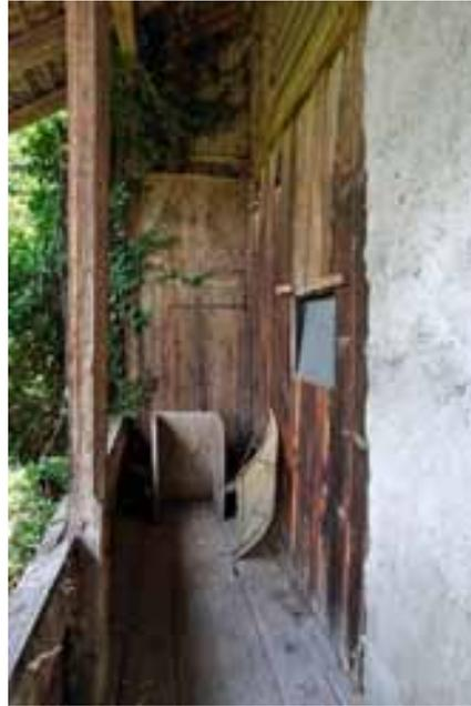
Abb. 32 (LINKS) – Talseite, bernseitige Scheune, Teilansicht von Süden. Die Stützmauer, deren Verputz im Laufe der Zeit abgefallen ist, wurde mit einem hölzernen Spalierrost bedeckt. Darüber befindet sich der Laubengang mit einem eigenen Dach, dahinter die mehrfach umgebaute Scheune von 1704.
