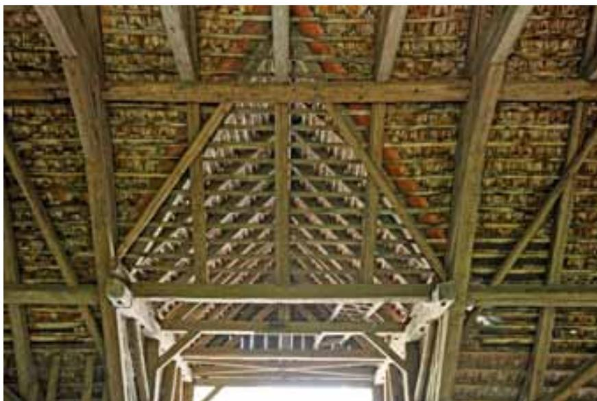
Abb. 136 – Bernseitige Scheune, Dachraum, Blick Richtung Nordosten in die Hocheinfahrt. Bis zur Mittelpfette läuft der Dachschild mit samt (leeren) Dachlatten durch. Die Hocheinfahrt ist genau zwischen zwei Binder eingestellt; das darunterliegende Tenn ist jedoch schmaler und nur thunseitig mit der Hocheinfahrt bündig (vgl. Abb. 21 und 22).
