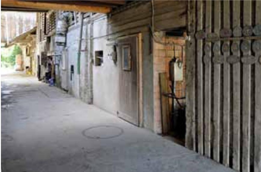
Abb. 25 – Bernseitige Scheune, Strassenseite, Ansicht von Norden. Im Vordergrund rechts die Lattenwand des Schuppenanbaus von 1895. Nach der Öffnung folgt der ehemalige Schweinestall, der in der 2. Hälfte des 20. Jhs. dort eingebaut worden war. Dahinter der Übergang vom verputzten Backsteinmauerwerk auf das Bruchsteinmauerwerk aus der Zeit um 1840. (Foto: PB/KDP 2018)
