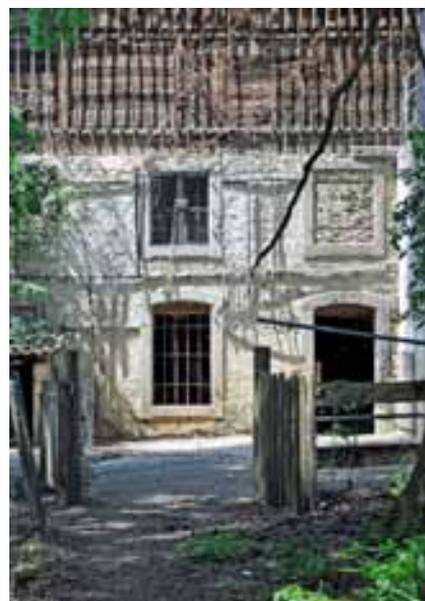
Abb. 52 (LINKS) & Abb. 53 (RECHTS) – Thunseitige Scheune, Sockelmauerwerk Seite Südosten. Auch auf dieser Seite sind die Speicherräume befenstert. Einige der Fenster wurden – unter Belassung der Gewände – bereits im 19. Jh. zugemauert. Die Tür zur Ecke hin (Abb. 52) entstand aus einem Fenster durch das Ausbrechen der Brüstung. (Fotos: PB/KDP 2017)
