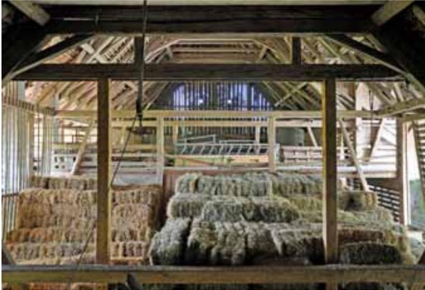
Abb. 122 – Blick vom Dachraum der thuseitigen Scheune in den hohen Bergeraum der bernseitigen Scheune. Die Bühne der Hocheinfahrt liegt in der bernseitigen Scheune auf einem Zwischenniveau und nicht auf der Höhe des «Dachbodens».
