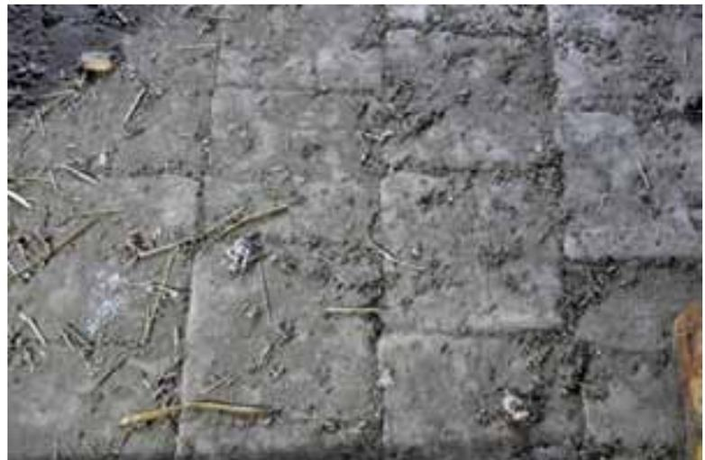
Abb. 70 (OBEN) – In allen drei Räumen des 1. Untergeschosses wurden als Gehschicht Tonplatten verlegt. Dieser Bodenbelag ist in Kornhäusern oft zu beobachten.
