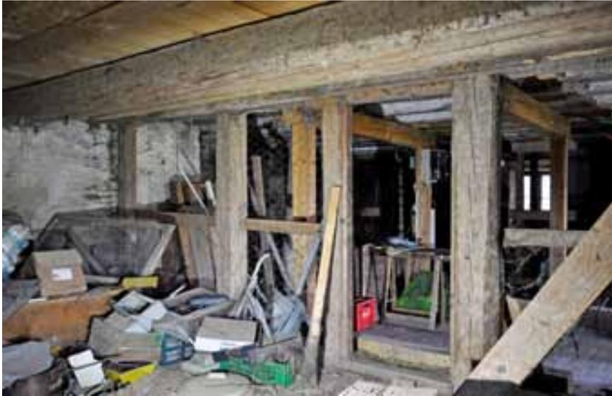
Abb. 69 – U1.03, Blick Richtung Osten in U1.02 und U1.01. Im Vordergrund oben die kurz nach 1800 ausgewechselten Deckenbalken – eine Massnahme zur Verstärkung des Tennbodens. Gut erkennbar das Holzgerippe der ehemaligen Fachwerkwand zum Korridor U1.02. Die Ausfachungen wurden später entfernt.
