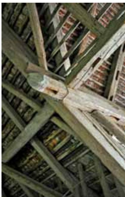
Abb. 138 (LINKS) – Bernseitige Scheune, Blick nach oben Richtung Norden. Zusammenschluss der Hocheinfahrt mit dem alten Dachstuhl. Für die Hocheinfahrt wurde 1898 zum Teil auch Bauholz wiederverwendet, wie die leeren Zapflöcher belegen.
