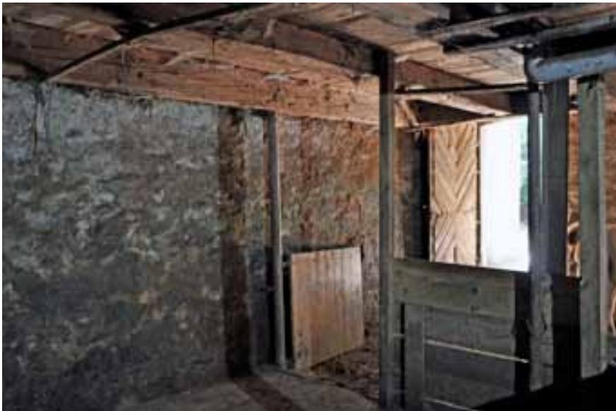
Abb. 60 – U2.01, Blick Richtung Osten. Die Tür ins Freie gehört, zusammen mit dem Türflügel, zum Ursprungsbestand aus der Bauzeit der thunseitigen Scheune im Jahr 1793. Im Hintergrund die erdberührte Mauer.
