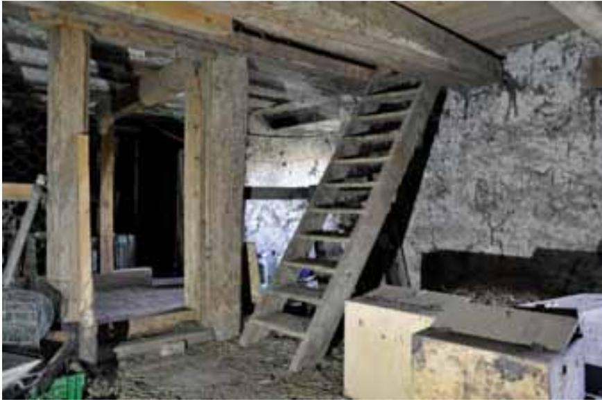
Abb. 66 – U1.03, Blick Richtung Süden in U1.02 und U1.01. Im Unterschied zum 2. Untergeschoss wurden im 1. Untergeschoss die Ausfachungen der Trennwände zwischen dem Erschliessungskorridor und den Kornkammern entfernt. Die steile Holz-
