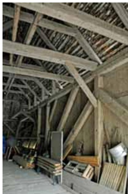
Abb. 131 (LINKS) – Thunseitige Scheune, Blick von aussen in die Hocheinfahrt. Das Dachwerk der Hocheinfahrt besteht aus einfachen Dreieckbindern. In der Mitte stabilisiert ein durchlaufender Balken die beiden Seitenwände.
