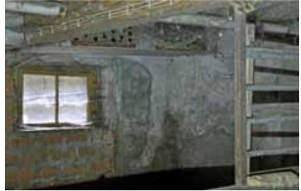
Abb. 109 – Bernseitige Scheune, Stall EG.16, Blick Richtung Osten. Der rechte Bereich des Mauerwerks stammt aus der Zeit um 1840, der linke unverputzte mit dem Fenster entstand erst mit dem Umbau zum Schweinestall in der 2. Hälfte des 20. Jhs. (Foto: PB/KDP 2017)
