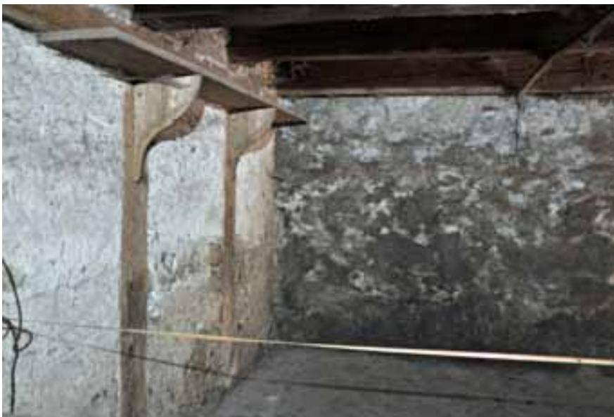
Abb. 61 – U2.01, Blick Richtung Nordosten auf die erdberührte Rückwand, die als Stützmauer zum Hang dient. Die Fachwerkwand links im Bild trennt den Kellerraum vom Korridor U2.02.
