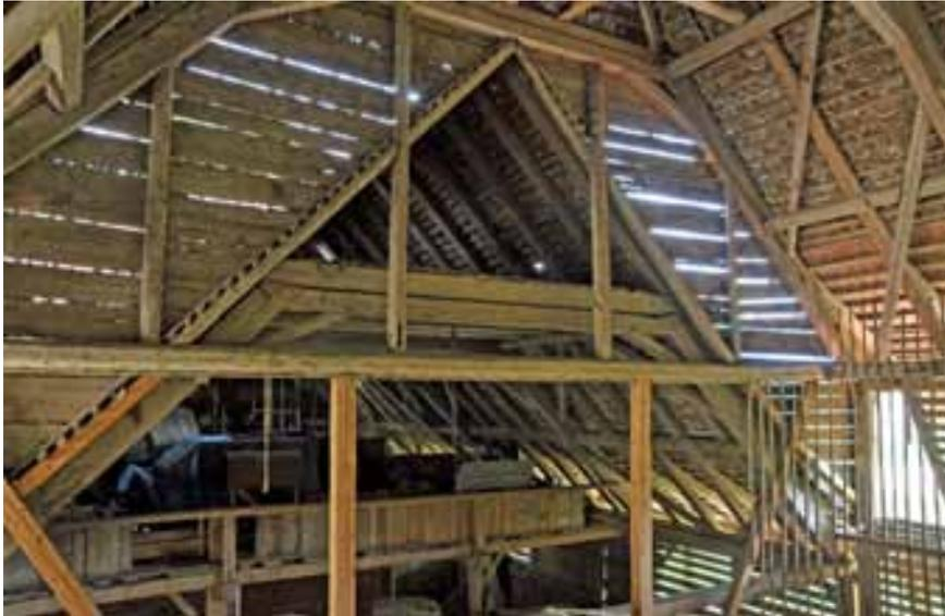
Abb. 133 – Bernseitige Scheune, Dachraum, Blick in Richtung der thunseitigen Scheune. Der letzte Binder der thunseitigen Scheune von 1793 ist gut ablesbar. Die eindrückliche Differenz zwischen dem tieferen und dem höheren Dachstuhl wird durch horizontale Bretter verschlossen. Das bergseitige Giebfeld (links) ist aussen mit Schindeln verkleidet, die unterdessen durch die Witterung stark reduziert worden sind. (Foto: PB/KDP 2017)
