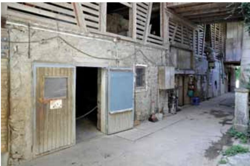
Abb. 19 – Bernseitige Scheune, Strassenseite, Ansicht von Süden. Das ursprünglich hölzerne Stallgeschoss wurde um 1840 in Mauerwerk erneuert, der Bergeraum 1898 faktisch um ein Stockwerk erhöht. In der Bildmitte das Tenn und darüber die Hoch-einfahrt, welche auf eine Bühne im Bergeraum führt. Das doppelflügelige Tor im Vordergrund ist eine Ergänzung aus der 20. Hälfte des 20. Jhs.; das benachbarte Fenster gehört zum ursprünglichen Bestand des Stallmauerwerks. (Foto: PB/KDP 2017)
