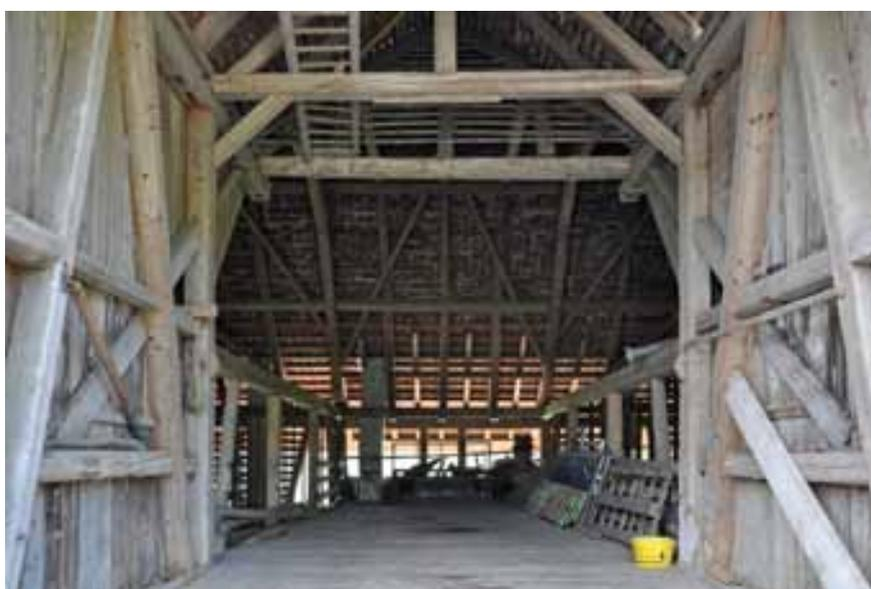
Abb. 137 – Bernseitige Scheune, Blick von der 1898 gebauten Hocheinfahrt in den Dachraum. Der Graben zwischen der Stützmauer und der Scheune wird durch je einen Dreiecksbinder in den Seitenwänden der Hocheinfahrt überwunden.
