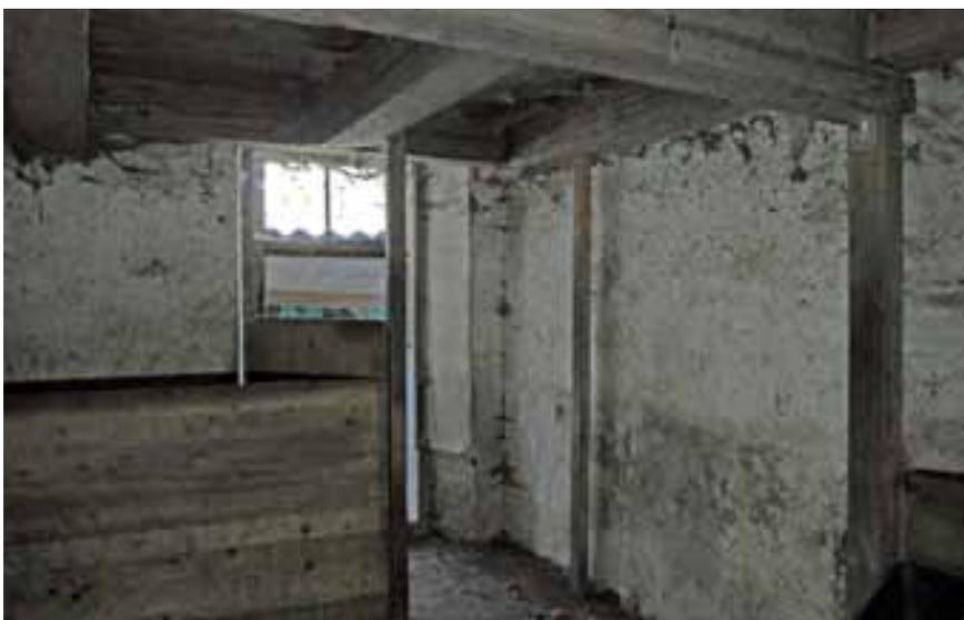
Abb. 57 – U2.01, Blick Richtung Süden. Die Tür im Hintergrund ist durch die Erweiterung eines Fensters entstanden. Die Wände sind mit einem Kalkmörtel deckend verputzt, der ursprünglich ohne Anstrich verblieb, später jedoch gekalkt wurde. Die Stallbauten stammen aus der jüngsten Vergangenheit.
