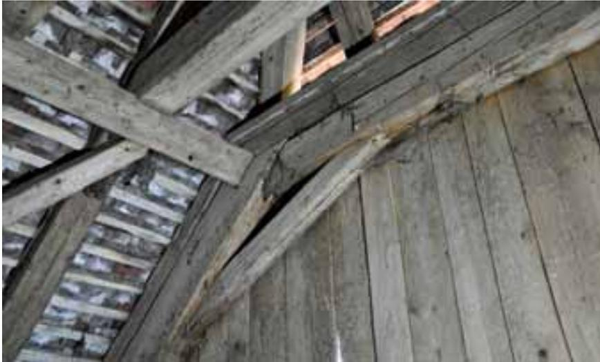
Abb. 128 – Thunseitige Scheune, Dachstuhl von 1793, Blick Richtung Osten in den Eckpunkt am Übergang zum Gerschild. Der letzte Dachstuhl-Binder liegt in der Ebene der Stirnwand. Der dortige Vorsprung ist bescheiden und wird lediglich durch zwei Stirnläden gebildet, die an der Unterseite der Dachlatung aufgenagelt sind. (Foto: PB/KDP 2017)
