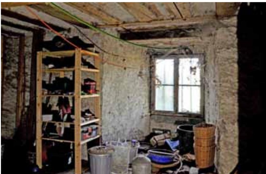
Abb. 72 – U1.02, Blick Richtung Südwesten in die tiefe Fenster niche. Hier, im Bereich des ursprünglichen Korridors, sind die Deckenbalken sehr eng verlegt und die Felder mit Backstein zu flachen Kappen ausgemauert.
