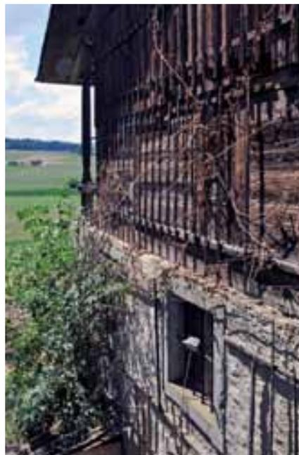
Abb. 50 (LINKS) – Talseite, thunseitige Scheune, Ecke, Blick auf den Übergang vom Sockelmauerwerk auf den Laubengang und den hölzerne Oberbau. Die Mauercke wird durch eine Quadierung aus Sandstein akzentuiert. Der giebelseitige Dachüberstand wird durch zwei Windladen gebildet. Der letzte Dachbinder befindet sich in der Wandebene.
