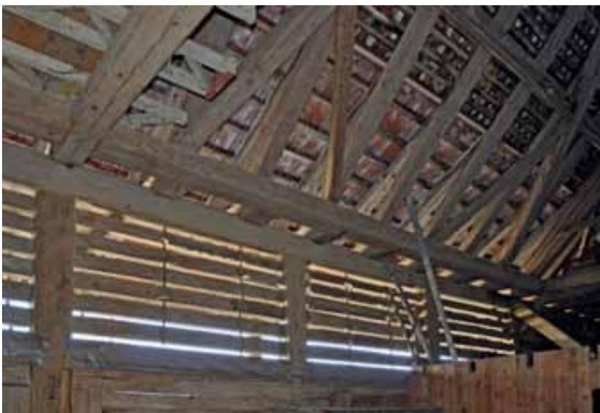
Abb. 115 – Thunseitige Scheune, Blick Richtung Westen. Auf ein korridorartig schmales Binderfeld folgt ein ungewöhnlich grosses; der nächste Binder folgt erst in der Ebene der thunseitigen Tennwand (ganz im Hintergrund). Gut sichtbar sind hier die Aufschieblinge, welche oben auf den Sparren und unten auf der Schüpfpfette aufliegen und befestigt sind.
