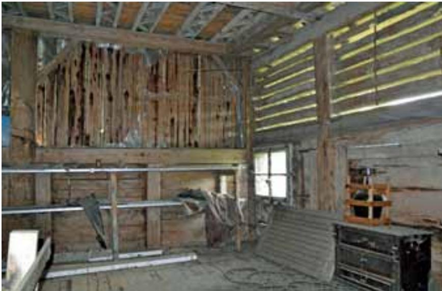
Abb. 79 – Thunseitige Scheune, Raumbereich thunseitig des Tanns, Blick Richtung Süden (Raumbereiche EG.03, EG.04, EG.05 und der darüberliegende Bergeraum OG.01). Die Binnenwände und die Decke zwischen Erd- und Obergeschoss sind entfernt. Das Erdgeschoss dieses Scheunenteils beherbergte wegen der darunter befindlichen zwei Stockwerke keine Stallungen, sondern Lager- und Speicherräume. (Foto: PB/KDP 2017)
