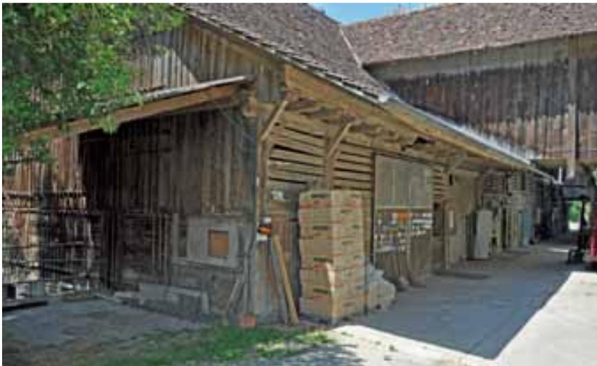
Abb. 14 – Thunseitige Scheune, Ansicht von Osten. Die Stirnseite und die Traufseite bis zum Schiebtor sind im Wesentlichen unverändert erhalten geblieben. Erd- und Obergeschoss sind zusammen abgebunden (durchlaufende Pfosten). Im Erdgeschoss bestehen die Ausfachungen aus liegenden Bohlen. Die Giebelwand darüber ist verbrettert; traufseitig ist das Obergeschoss, wo sich der Bergeraum befand, mit einer Gimwand versehen. Im Hintergrund ist die Hocheinfahrt zu sehen.
