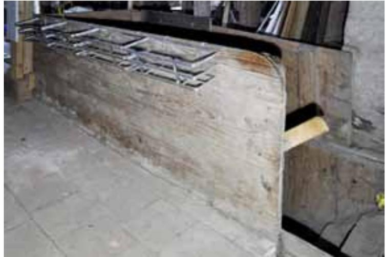
*Abb. 76 (OBEN) – U1.01, Blick Richtung Westen auf die nachträglich eingebaute Brüstung des Treppenabgangs ins 2. Untergeschoss. Man beachte auch den Tonplattenboden.*
