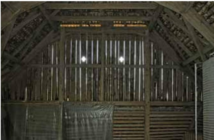
Abb. 141 – Bernseitige Scheune, Blick von der Hochfahrtsbühne Richtung Nordwesten auf die bernseitige Stirnwand, die in dieser Form in Zusammenhang mit der Aufstockung des Bergeraums 1898 geschaffen wurde. Der letzte Dachbinder steht in der Ebene der Stirnfassade. Ein einfaches Holzgerüst dient als Träger der vertikalen Verbretterung. Die beiden Schweizerkreuze als Lichtausschnitt sind ein gängiges Motiv in der 2. Hälfte des 19. Jhs.
