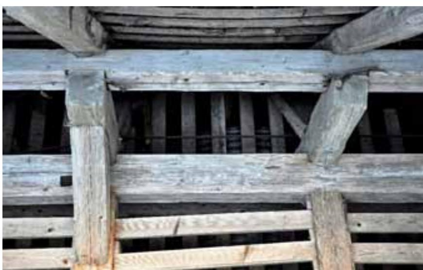
Abb. 24 – Bernseitige Scheune, Strassenseite, Übergang von der Wand auf das traufseitige Vordach. Die über die Wandebene nach aussen vorspringenden Stichbalken tragen eine Schüpfipfette, auf der die Sparren-Aufschieblinge lagern. Wandpfette, Stichbalken, Bug, Schüpfipfette und die Aufschieblinge gehören zur ersten Scheune von 1704, die im 18. Jh. um 90 Grad gedreht neu aufgerichtet worden war und 1898 – unter Weiterverwendung des ursprünglichen Dachstuhls – aufgestockt wurde. (Foto: PB/KDP 2017)
