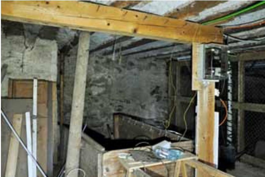
*Abb. 73 – U1.02 und U1.01, Blick Richtung Nordosten auf die Rückwand. Links ist der Versatz in der Mauer zu erkennen. Über dessen Ursache kann nur gemutmasst werden: Wich man anstehendem Fels aus? Der neue Holzbalken und der Pfosten haben keine statische Funktion, sondern dienen der jüngeren Nutzung. (Foto: PB/KDP 2017)*
