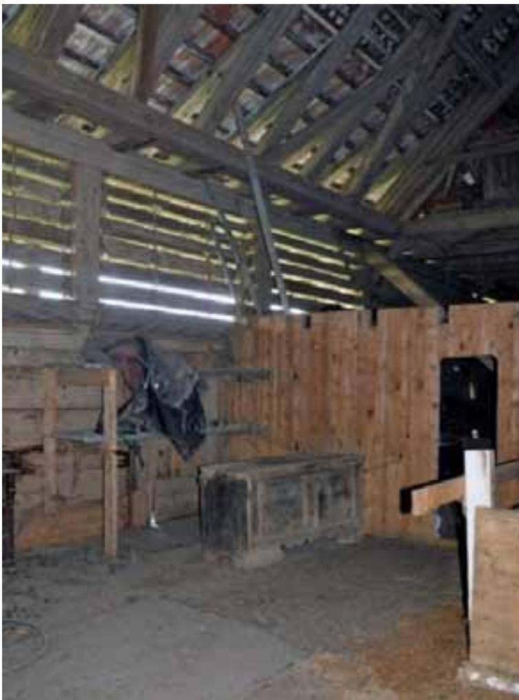
Abb. 84 (OBEN) – Thunseitige Scheune, Raumbereich thunseitig des Tennis, Blick in Richtung Westen. Gut zu erkennen ist die statische Struktur der Scheune mit der Gimwand im ehemaligen Bergeraum und der einspringenden Pfette, in welche die Stichbalken eingezäpft sind, die die Schüpppfette des Vordachs tragen.
