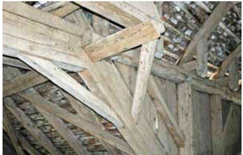
Abb. 129 (OBEN) – Thunseitige Scheune, Blick Richtung Norden auf den Übergang von der ursprünglichen Hocheinfahrt auf den Dachstuhl. Die Mittelpfette lief ursprünglich durch und wurde später wegen der zunehmenden Höhe der Heuwagen weggesägt. – Abb. 130 (LINKS) – Thunseitige Scheune, Blick von der Hocheinfahrt in den Dachraum. (Fotos: PB/KDP 2017)
