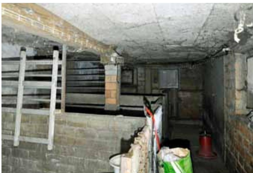
Abb. 107 – Bernseitige Scheune, Stall EG.16, Blick Richtung Südwesten. Das ursprüngliche Aussehen des Raums, insbesondere der bernseitige Abschluss, der gleichzeitig die Aussenwand der Scheune bildete, konnte nicht mehr einwandfrei nachvollzogen werden. Der Raum erhielt seine heutige Gestalt mit dem Umbau zum Schweinestall in der 2. Hälfte des 20. Jhs. (Foto: PB/KDP 2017)
