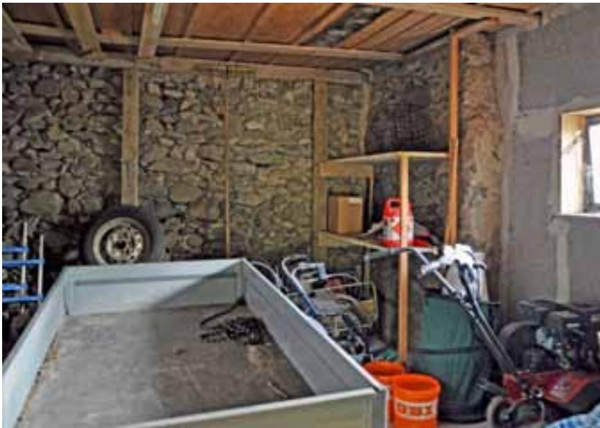
Abb. 110 – Bernseitige Scheune, Raum EG.17, Blick Richtung Südosten. Das unverputzte Bollensteinmauerwerk im Hintergrund stammt aus der Zeit um 1840 und trennt den Stall EG.15 von diesem Raum, der möglicherweise als Remise diente. Die gleichzeitig entstandene Mauer an der Talseite (rechts im Bild) endet hier mit einer Leibung, die eine Tür oder ein Tor markiert.
