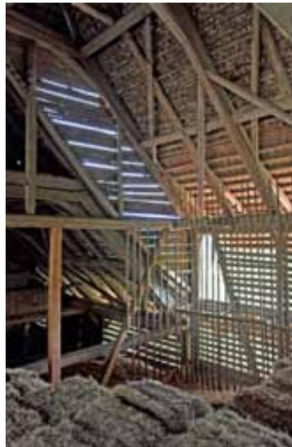
Abb. 119 (LINKS) & Abb. 120 (RECHTS) – Bernseitige Scheune, Bergeraum und Dachwerk, Blick Richtung Osten (LINKS) und Süden (RECHTS). Im Hintergrund ist die anstossende thunseitige Scheune zu sehen. Der überhohe Bergeraum entstand 1893, wobei der alte Dachstuhl der Scheune von 1704 weiterverwendet wurde. Konstruktiv sind die Dachstühle der beiden Scheunen identisch. Sie gleichen sich auch in den Details, obwohl eine zeitliche Distanz von rund neun Jahrzehnten zwischen ihnen liegt.
