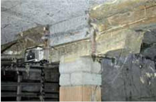
Abb. 108 – Bernseitige Scheune, Stall EG.16, Blick auf die Stütze in Raummitte, die einen Unterzug mit einem improvisierten Sattelholz trägt. Der Umbau erfüllte rein nutzungsmässige Ansprüche.
