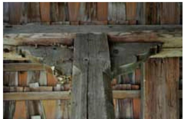
Abb. 36 – Talseite, Laubengang, Übergang von der bernseitigen zur thunseitigen Scheune, Blick nach oben. Die gedrechselte Säule stammt aus dem Jahr 1793, die Wandpfette und die Brettkonsole von der Aufstockung 105 Jahre später.
