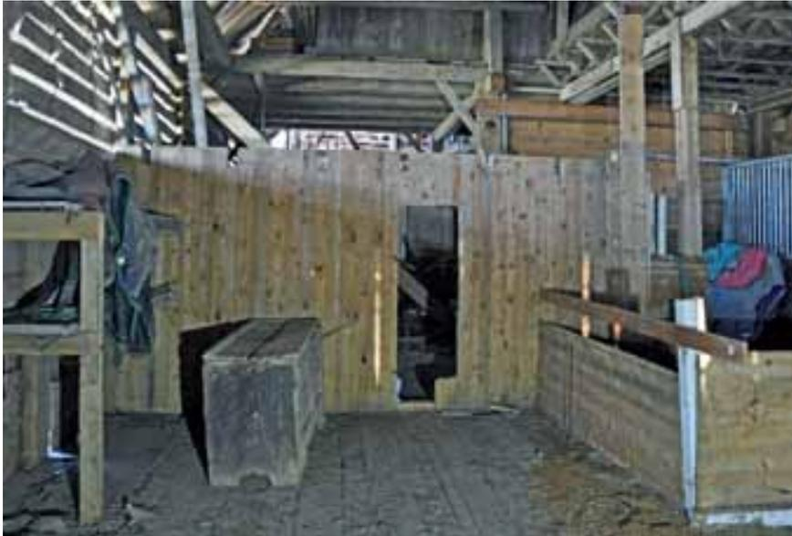
Abb. 82 – Thunseitige Scheune, Raumbereich thunseitig des Tennis, Blick Richtung Nordwesten. Die Innenwände und die Decke zwischen Erd- und Obergeschoss sind entfernt (vgl. auch Abb. 79 & 80). Zahlreiche Einbauten zeugen von jüngeren und jüngsten Nutzungsanpassungen.
