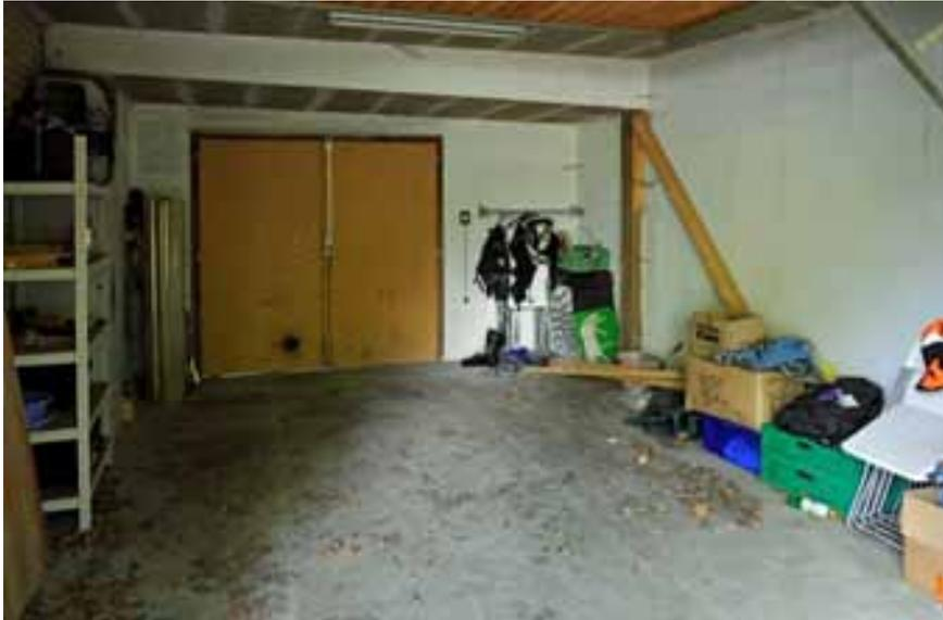
*Abb. 112 – Bernseitige Scheune, Einstellraum EG.20 im bernseitig angebauten Schopf, Blick Richtung Südosten. Die Scheune endete ursprünglich auf der Ebene des hölzernen Unterzugs. Später wurde die Raumtiefe der bernseitigen Scheune vergrössert. Das doppelflügelige Tor in der neuen Wand im Hintergrund erschliesst die ehemalige Remise EG 17. (Foto: PB/KDP 2017)*
