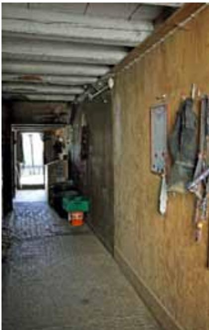
Abb. 92 – (LINKS) – Thunseitige Scheune, Pferdestall EG. 09, Blick Richtung Südwesten. Die Wand zur benachbarten (bernseitigen) Scheune ist mit Holzwerkstoffplatten verkleidet.
