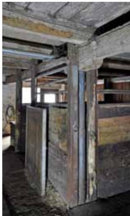
Abb. 99 (LINKS) & Abb. 100 (RECHTS) – Bernseitige Scheune, Stall EG.12, Blick Richtung Süden (LINKS) und Richtung Osten (RECHTS). Die Balkenlage wird in Raummitte durch einen Unterzug gestützt, der wiederum von zwei Stahlsäulen aufgefangen wird. Der Stall wurde im frühen 20. Jh. saniert, wobei die Mauer zum Tenn (rechts im Bild) mitsamt der Futterkrippe neu erbaut wurde. Die Decke behält in konventioneller Art eine Holzbalkenlage. (Fotos: PB/KDP 2017)
