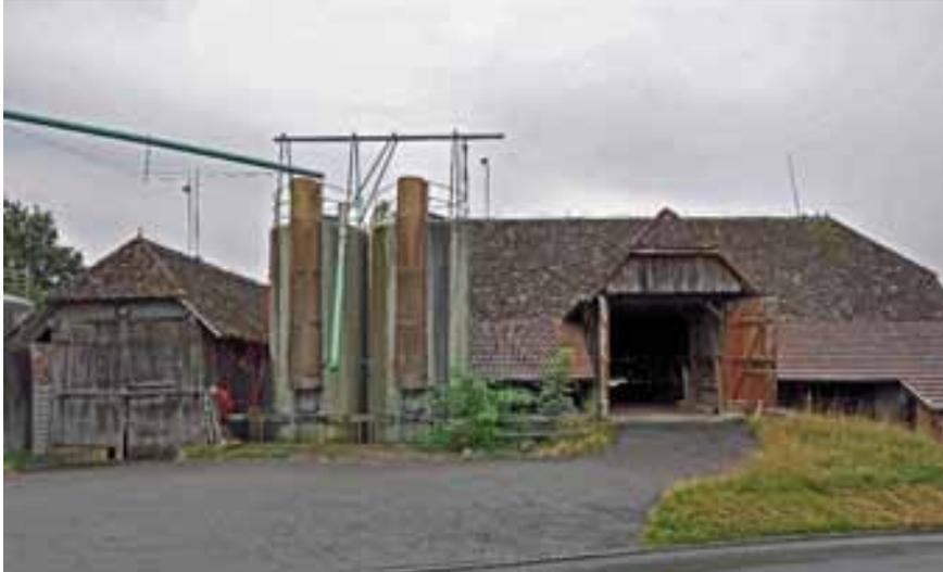
Abb. 13 – Strassenseite, Ansicht von Nordosten. Links der beiden Silos die Hocheinfahrt der thunseitigen Scheune, die von der Strasse aus praktisch horizontal zu erreichen ist. Rechts die bernseitige Scheune, deren Dach höher liegt, mit der Hocheinfahrt. Rechts (mit dem vorgezogenen Dachschild) ist ansatzweise die «Schnäzbudigg» zu erkennen.
