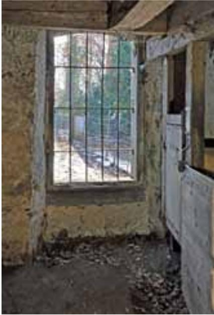
Abb. 58 (LINKS) – U2.01, Blick Richtung Südosten auf das mittlere Fenster. Weil die Deckenbalken über den Fenstern kein Auflager finden (zu tief!), werden sie mittels Wechsel aufgefangen (vgl. Plan Untergeschoss 2.
