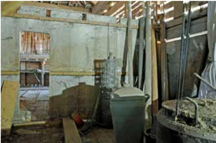
Abb. 87 – Thunseitige Scheune, Raumbereich thunseitig des Tenns, ehemaliger Speicherraum EG.06, Blick Richtung Südosten. Rechts ist die talseitige Aussenwand zu sehen. Die ursprüngliche Raumteilung fehlt, die Einbauten stammen alle aus der 2. Hälfte des 20. Jhs. (Foto: PB/KDP 2017)
