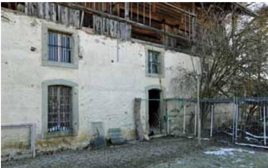
Abb. 47 – Talseite, thunseitige Scheune, Blick von Westen auf das Sockelmauerwerk. Die Räume im Sockel wurden als Lager und Kornspeicher genutzt, was mündlich und in Schriftquellen überliefert ist. Nutzungstypisch ist die Vergitterung der Fensteröffnungen mit Eisenstäben. Der Sockel der thunseitigen Scheune entstand 1793, als die alte Scheune durch einen fast gleichgrossen Neubau erweitert wurde. Auf der Mauerkrone verläuft ein Laubengang. (Foto: PB/KDP 2017)
