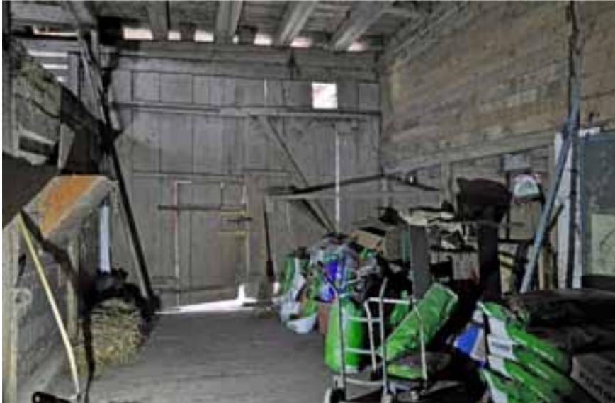
Abb. 90 – Thunseitige Scheune, Tenn EG.07, Blick Richtung Nordosten auf das bergseitige Tennstor. Oben die Balkenlage der Hocheinfahrtsbühne, links die ursprüngliche Wand zum Pferdestall, rechts die neu verbretterte Wand zum Raumbereich thunseitig des Tenns.
